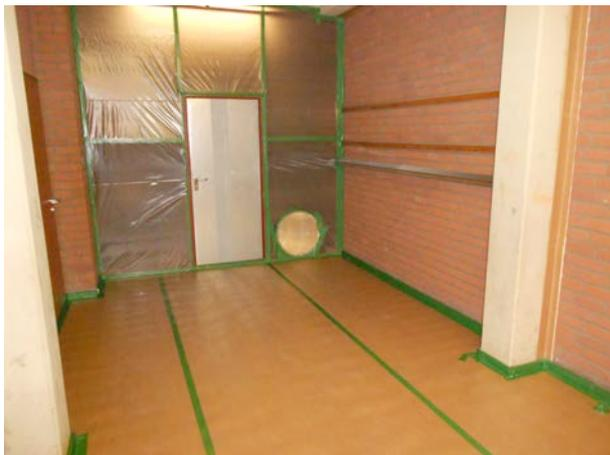
*Bild 3: Abdeckung Tür zum Treppenhaus mit Belüftungsöffnung*
