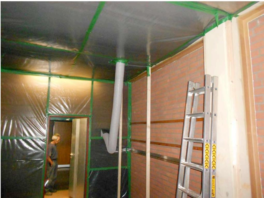
*Bild 5: Belüftung der Messzelle unterhalb der Deckenkonstruktion*
