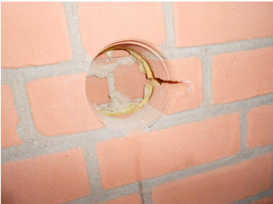
*Bild 11: Kernbohrung durch die 1. Klinkerschicht der Klinkerwand des Flures*
