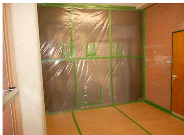
*Bild 4: Abdeckung Außentür mit zugeklebten Belüftungsöffnungen*
